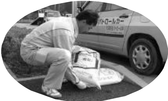
凍結に備えて道路端に凍結防止剤を配布
