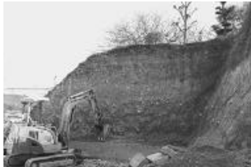
地層が現われた斜面(猪瀬口バス停付近)
