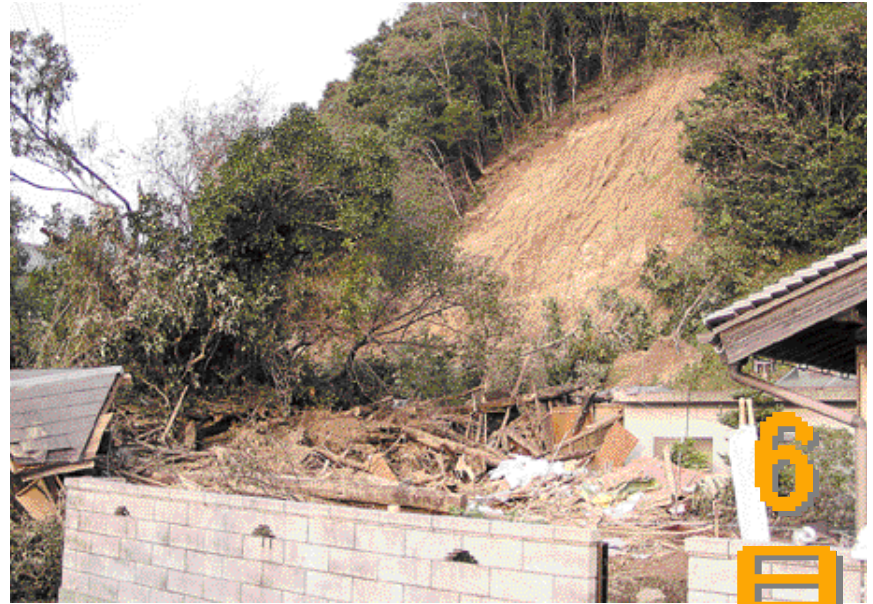
土砂災害による家屋倒壊(兵庫県内)
