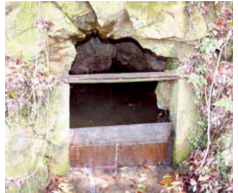
▲屏風岩の井堰
