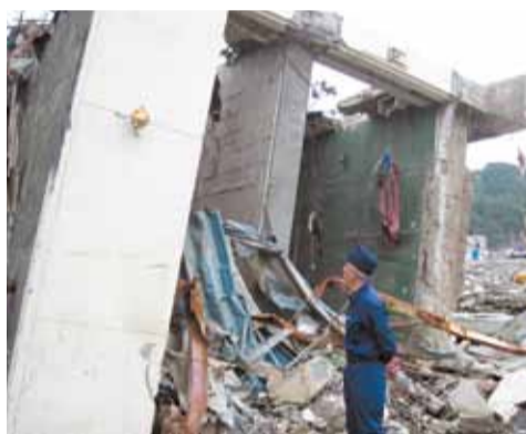
▲保存が決定している女川交番を前に津波の脅威とその被害を実感 (女川町)
