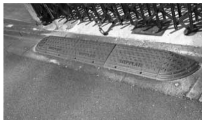
▲通行の障害になり危険な段差解消ブロック
