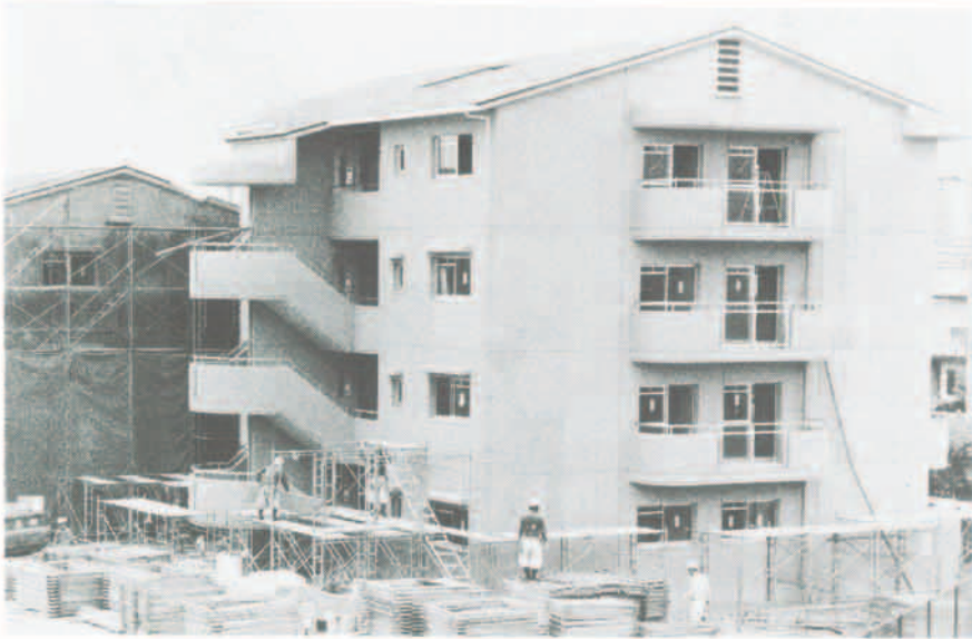
完成まで後わずか、急ピッチで工事が進む
