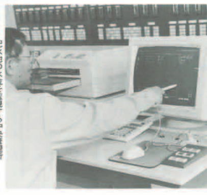
配水池の水位を監視する中央管理所
