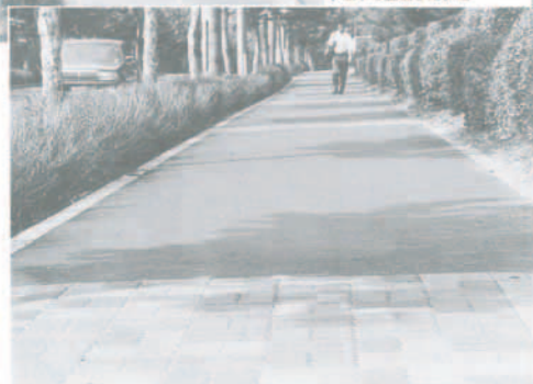
◀道路幅員24mの都市計画道路 川西猪名川線 ▼インターロッキングブロックや低木で整備した歩道
