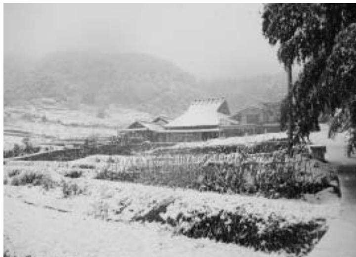
柏原地区のわらぶき家屋に降り積もる雪
