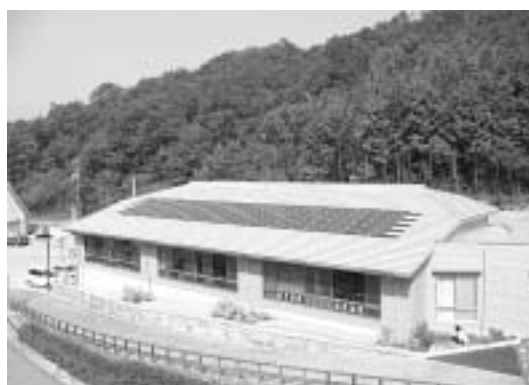
障害者福祉センターに設置された太陽光発電システム
