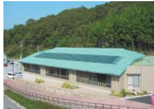
障害者福祉センターに設置された太陽光発電システム
