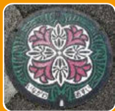
カラーデザインマンホール
