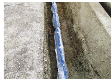
図1：ダクタイトル鉄管(GX形)への入替工事
