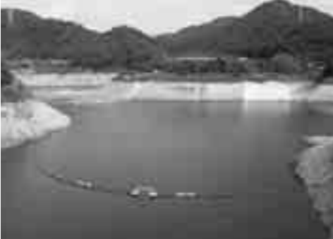
住民の水がめ “一庫ダム”
