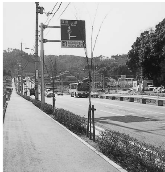
着々と進む道路工事（差組）
