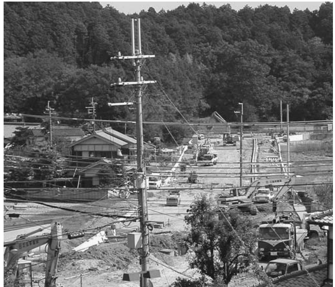
高速道路完成を見込んで整備される上野5号線
