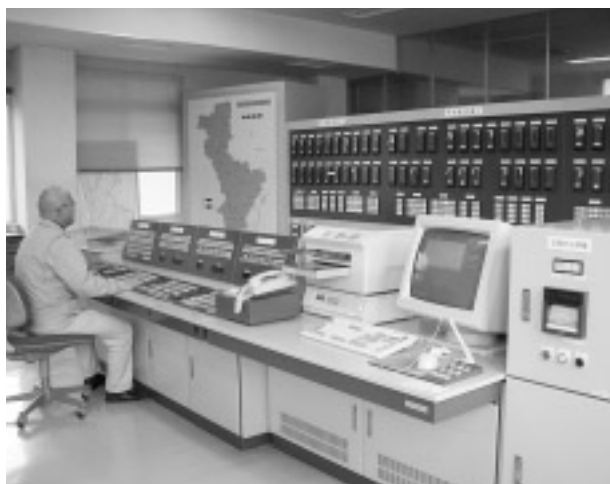
水道庁舎に一元化される中央管理所（笹尾）
