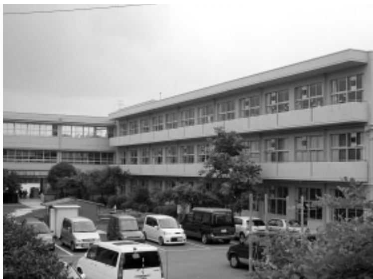
地域での活用が求められている余裕教室
