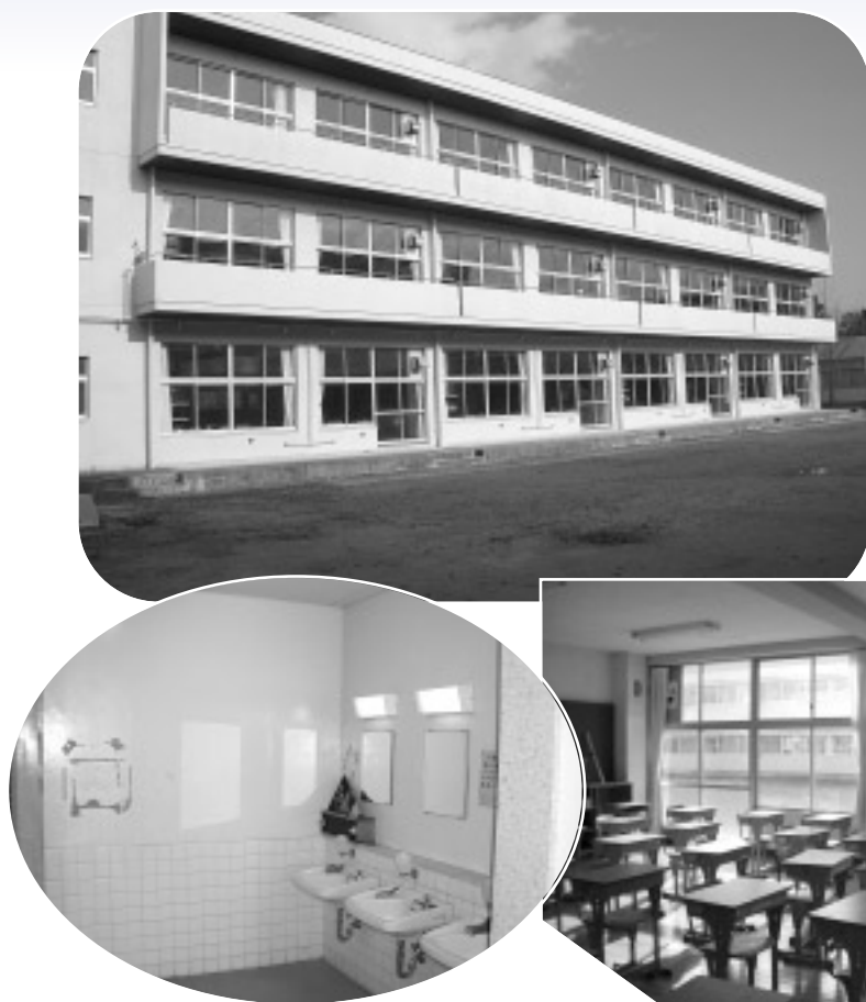
耐震補強・改修工事が実施される中谷中学校
