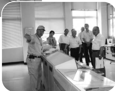
中央管理所監視室（笹尾）
