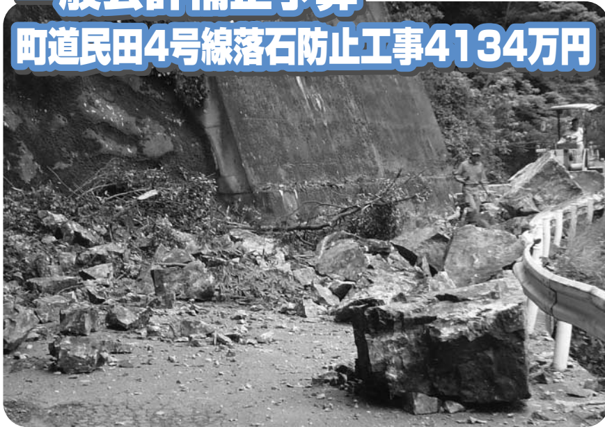
民田での落石現場
