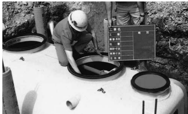
合併浄化槽設置工事
