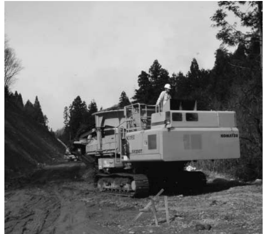
工事が進む木間生旭ヶ丘線
