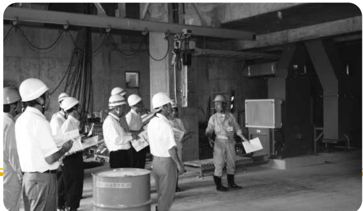
建設現場を視察する委員 (国崎クリーンセンター)
