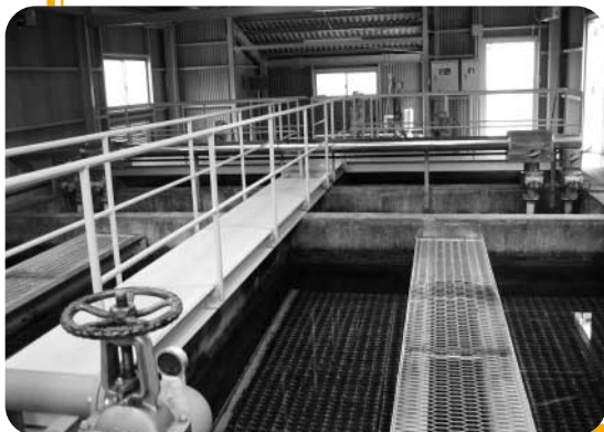
笹尾浄水場 薬品沈殿槽
