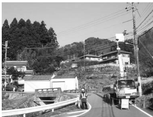
光ファイバの敷設工事(相原地区)
