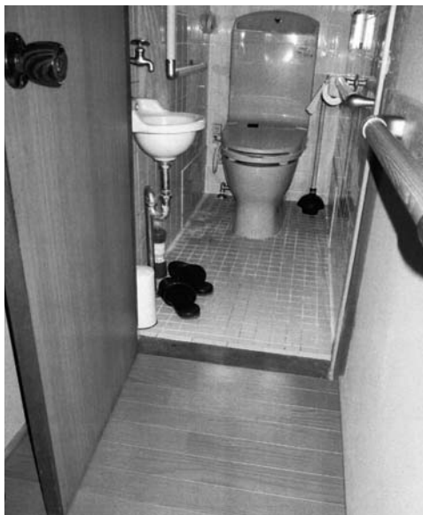
地元業者でリフォームされたトイレ
