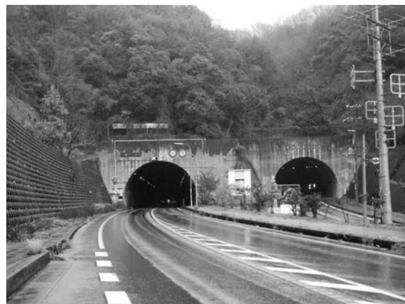
国道173号線のトンネル
