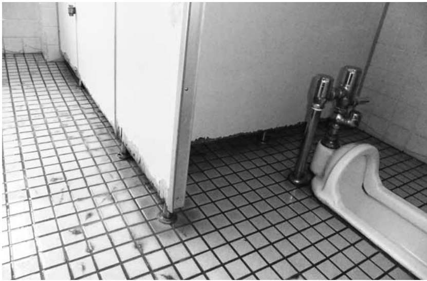
乾式の洋式トイレに改修される猪名川中学校の和式トイレ
