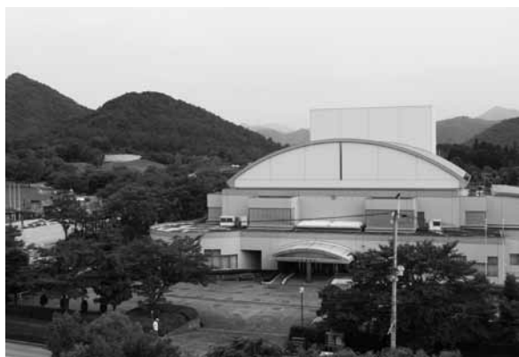
リニューアル工事が完了し、綺麗になったイナホール
