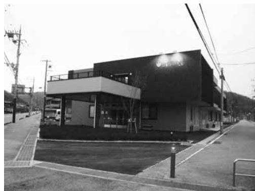
北部地域に新設された小規模介護老人保健施設(鎌倉地内)
