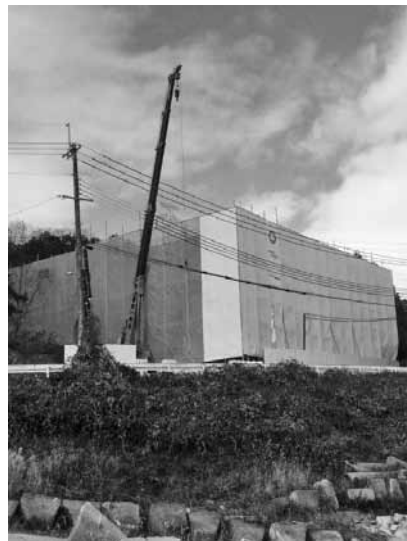
建設が進む児童養護施設 (仮称) 猪名川子供の家
