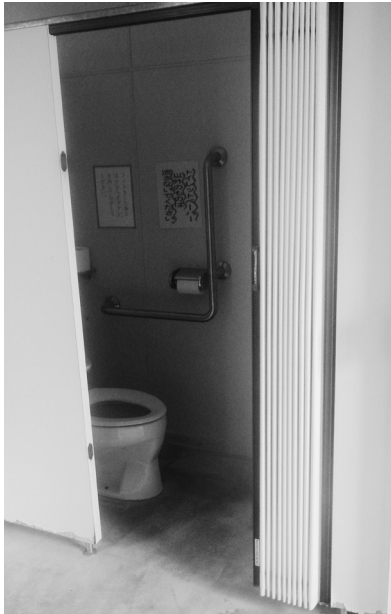
スポーツセンターグラウンド管理棟のトイレ
