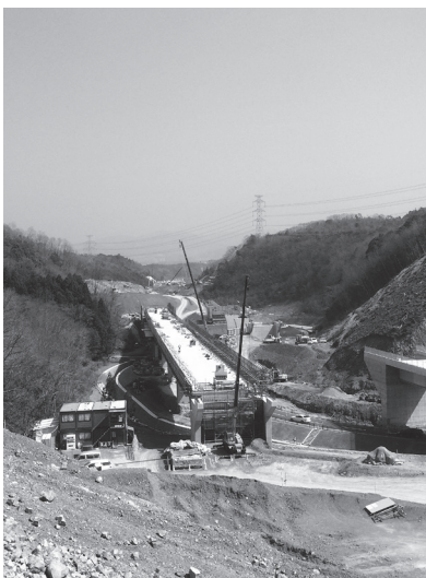
切畑トンネル入口から猪名川西工事現場を望む
