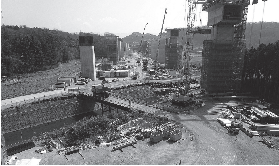
工事が進む新名神高速道路（六石山トンネル東側）
