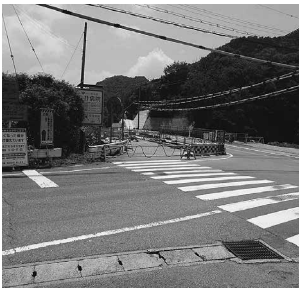
工事中の烏帽子岩橋
