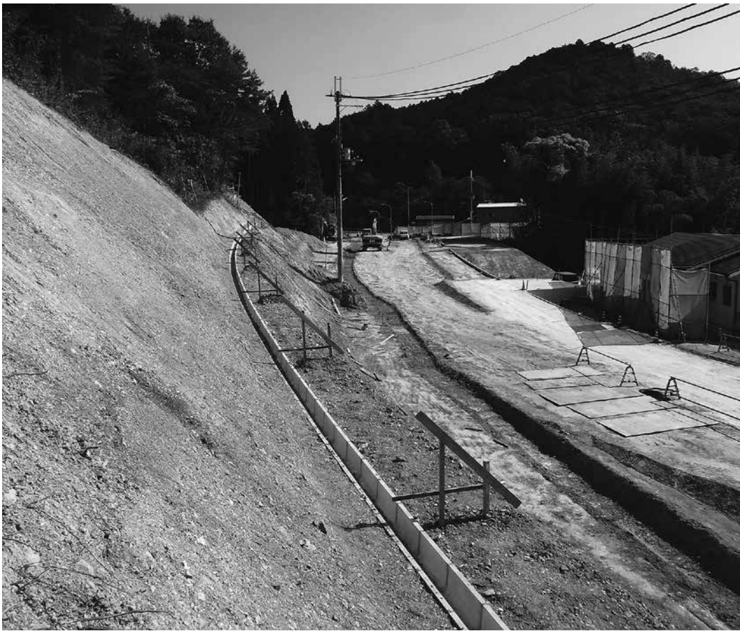
工事中の都市計画道路原広根線
