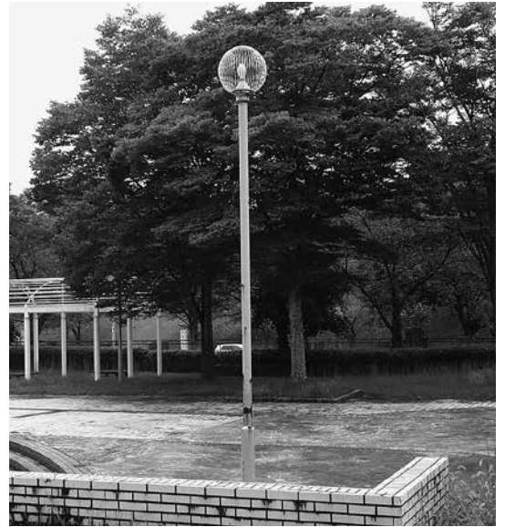
LED化されていない公園照明灯
