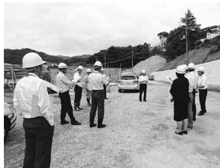
都市計画道路原広根線道路 新設改良事業
