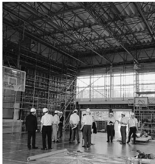
体育館の吊り下げ器具耐震化工事の様子 (猪名川小学校)
