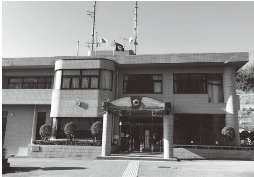
消防本部庁舎内を一部改修
