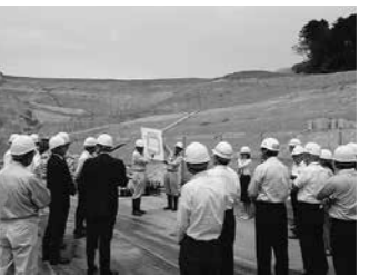
肝川地区の工事現場
