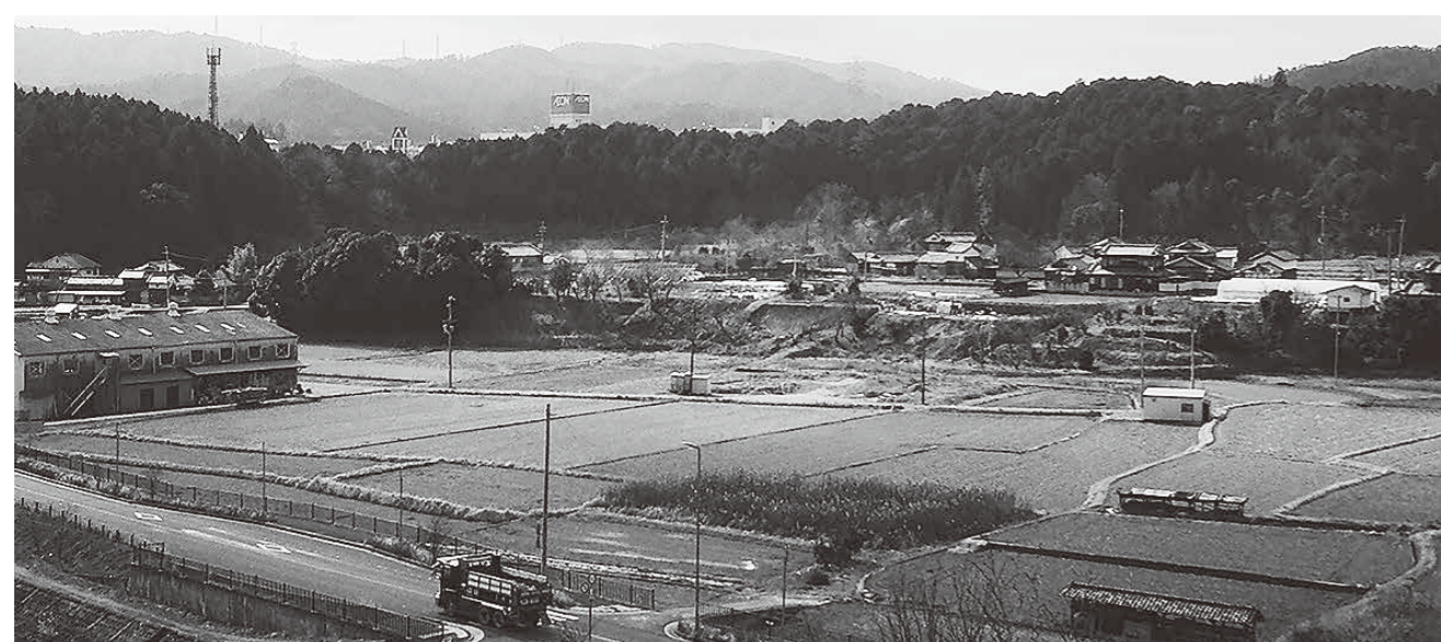
「道の駅いながわ」の建設予定地周辺(南田原地区)
