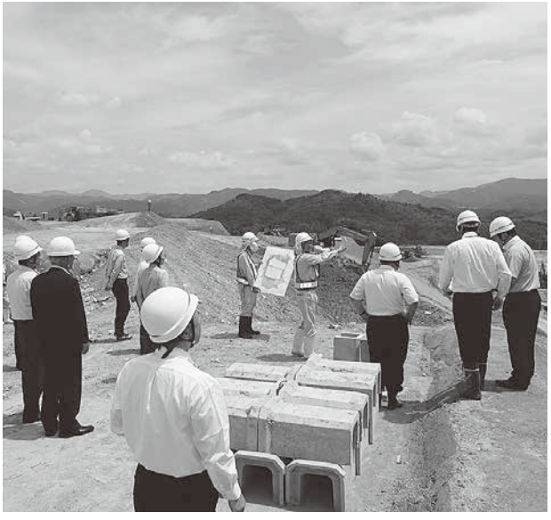
産業拠点地区の造成工事を現地視察
