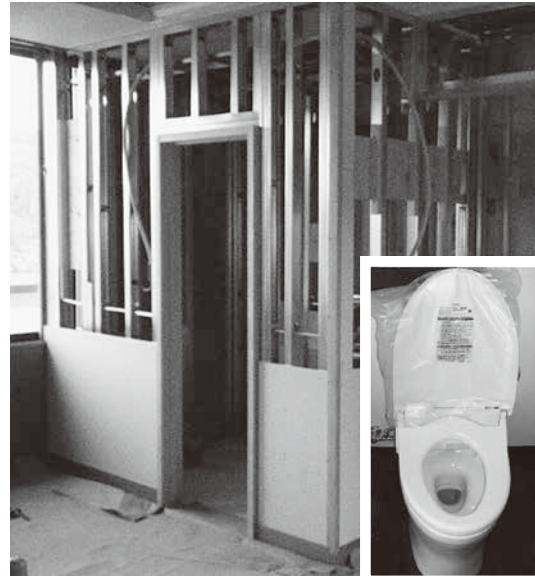
町長室にもトイレを新設
