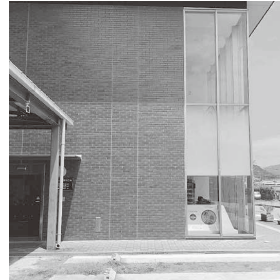
第二庁舎階段部分のガラス面
