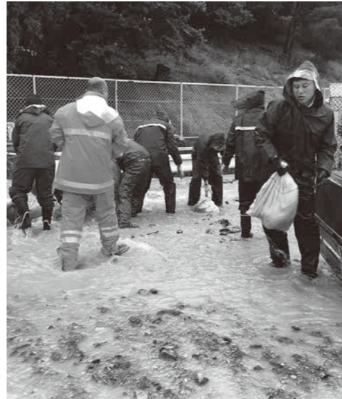
災害現場の復旧作業（伏見台地区）
