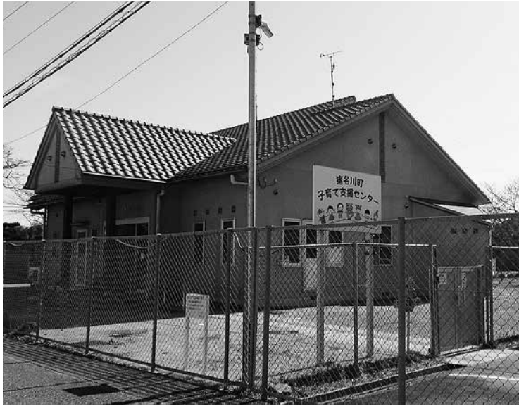
電気錠の設置で利用者の安全を確保する子育て支援センター
