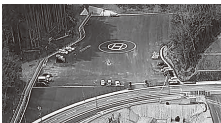
プロロジス内の防災広場(写真中央)
