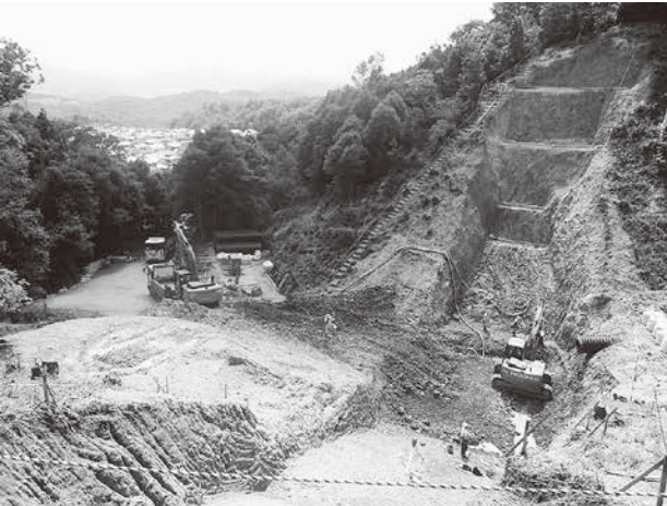
現在進められている砂防工事(伏見台隣接地)
