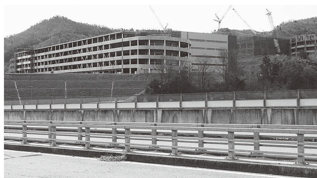
建設中のプロジスパーク(差組地区)
