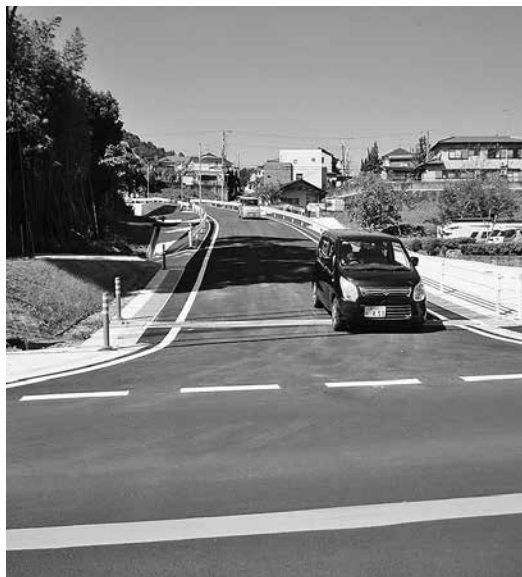
猪名川荘苑に新設された町道
