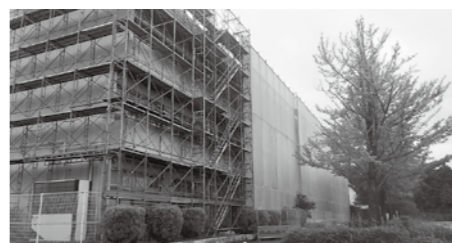
再編に向けて工事が進む中谷中学校
