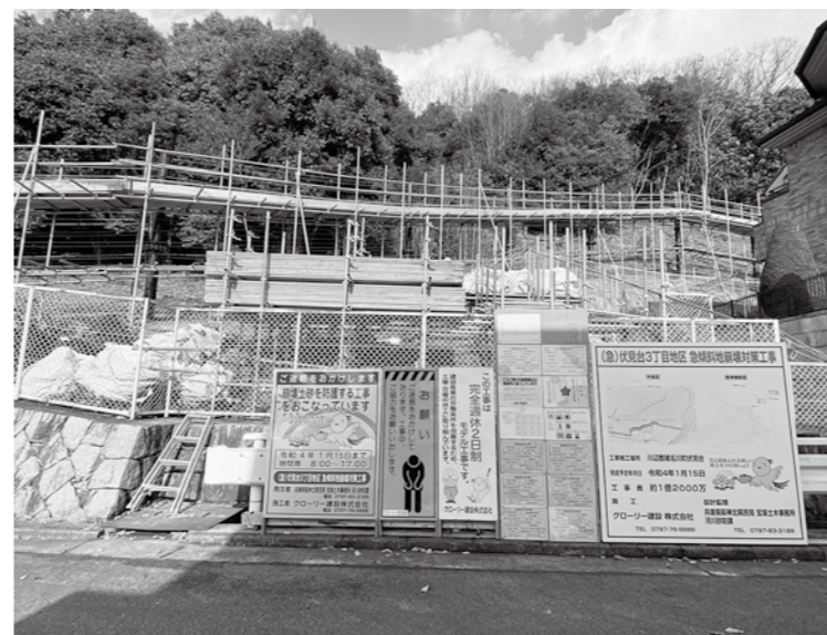
急傾斜地の工事(伏見台3丁目)
