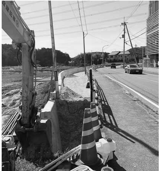
紫合橋道路拡幅工事中
