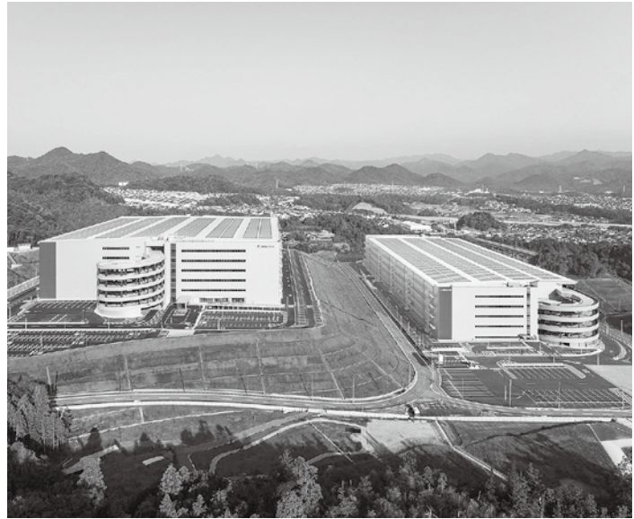
プロロジスパーク猪名川1・2(竣工写真)
