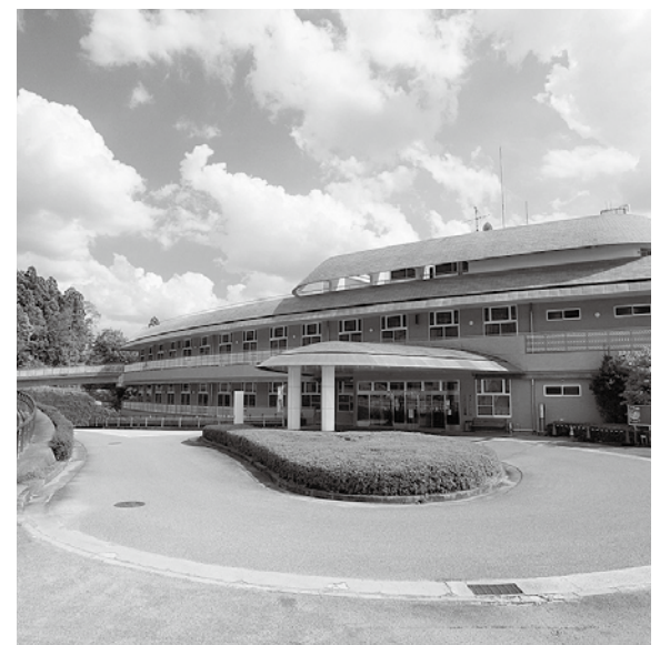
改修が望まれるゆうあいセンター
