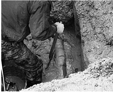
配水管入れ替え工事
