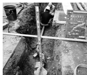
配水管入替工事（荘苑地内）
