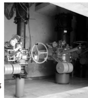
緊急遮断弁設置工事（白金高区配水池）
