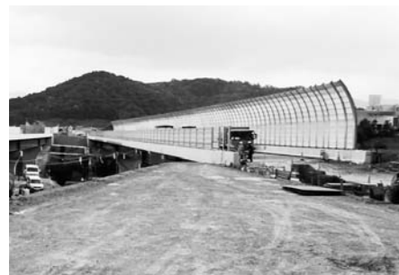
整備が進む遮音壁
