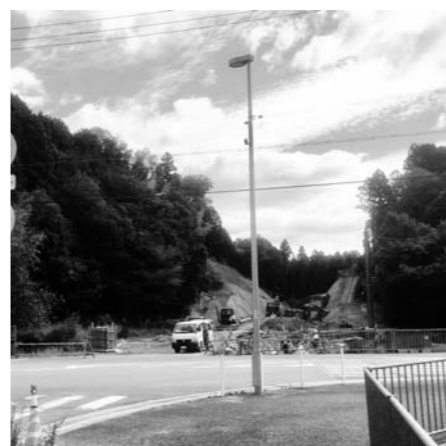
工事が進む新たな交通量調査ポイント（上野地内）
