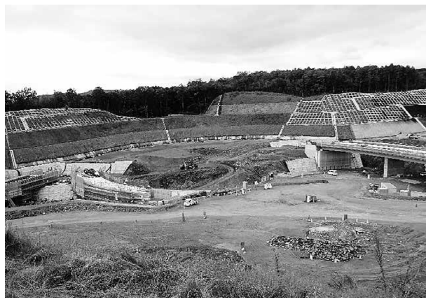
(仮称)川西インターチェンジの工事現場現状
