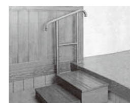
玄関の手すり
