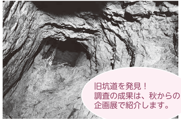
整備にあわせて 坑道内の調査をしました
