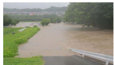
図 2-29 平成 30 年(2018 年)7 月の大雨による猪名川町災害情報(通行止め情報)より
