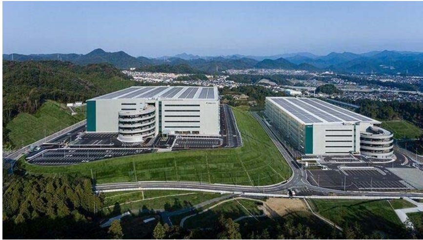
図 2-13 プロロジス猪名川プロジェクトが完成
